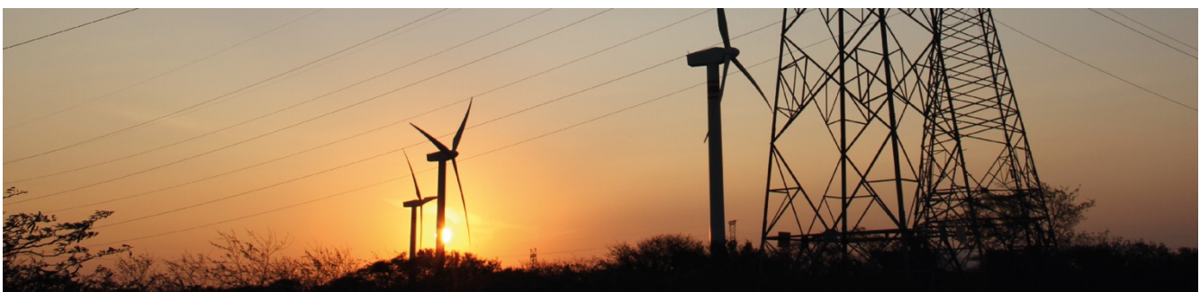
Eólica. Generadores eólicos. | Comisión Federal de Electricidad.
